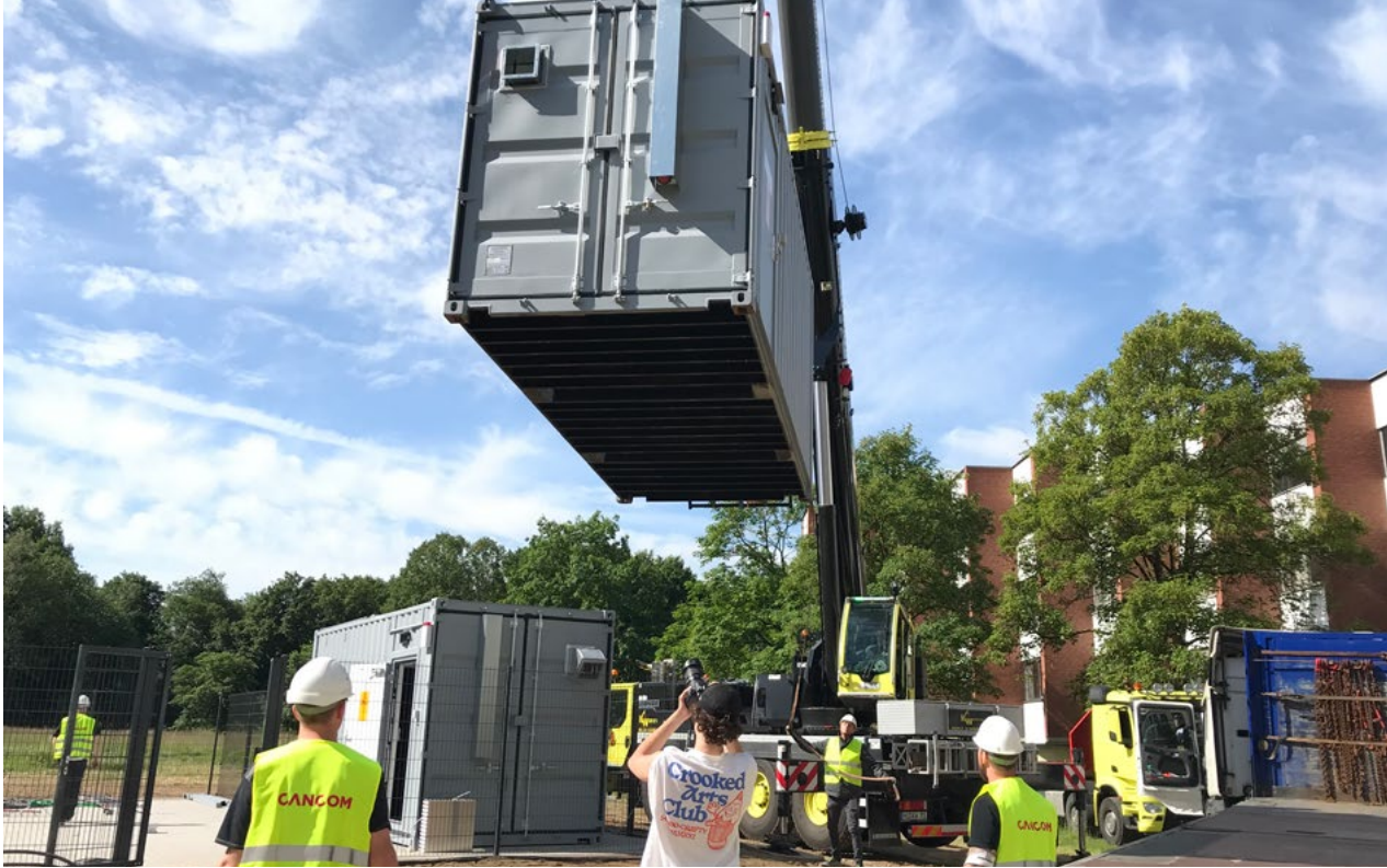
Verladung bei CANCOM Physical Infrastructure, Kempten: Hier werden die RZ-Container gebaut.
